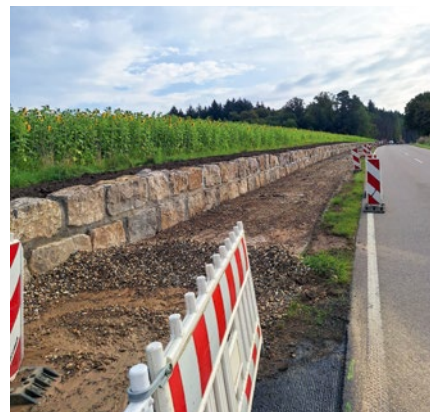
Die neue Naturstein-Stützmauer entlang des Rad- und Fußweges von Beuren nach Illerrieden
