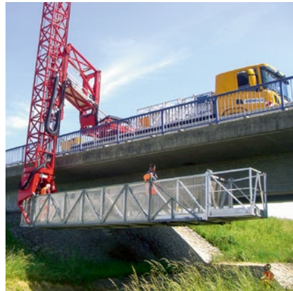
Prüfung der Donaukanalbrücke bei Erbach
