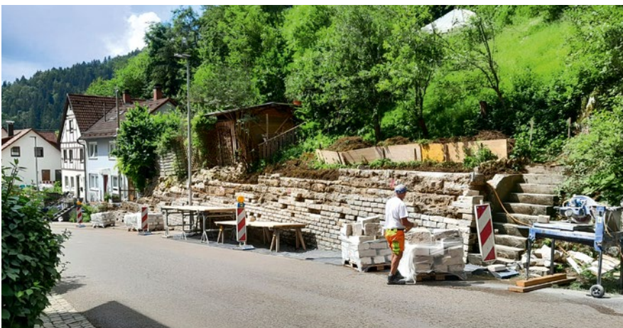
Sanierung der Stützmauer in Blaustein-Ehrenstein
