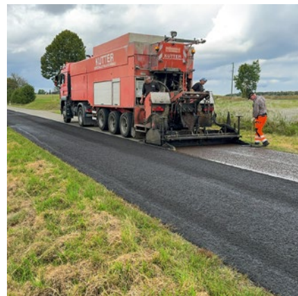
DSK (Dünne Schichten in Kaltbauweise) Einbau zwischen Frankenhofen und Grötzingen
