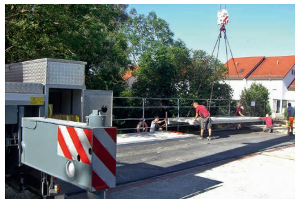
Sanierung der Kreisstraßenbrücke in der Ortsdurchfahrt Dellmensingen, Einbau Brückenkappen
