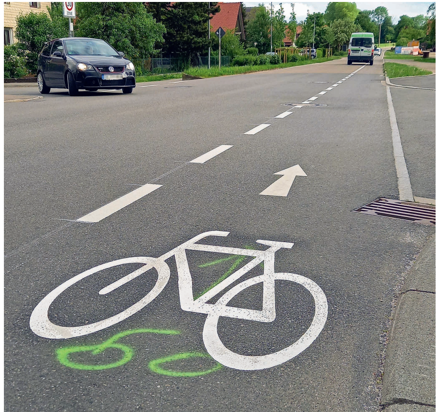
Markierung des neuen Fahrradschutzstreifens auf der Suppinger Straße in Laichingen
