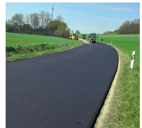
Belagssanierung zwischen Altheim und Ringingen
