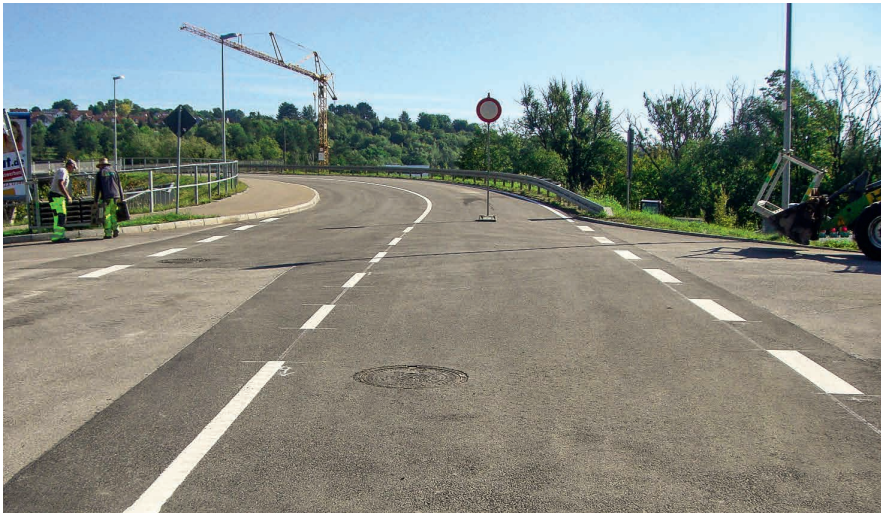
Asphaltdeckschicht- und Brückenübergangssanierung in der Kurt-Mühlen-Straße in Blaustein
