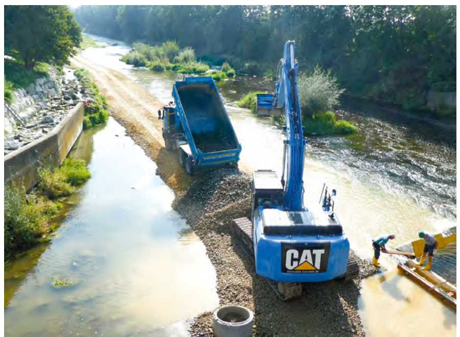
Herstellen der Baustraße in die Donau
