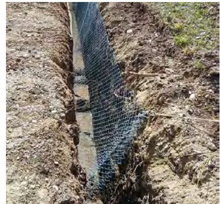
Biberschutz: gegen Untergraben des neuen Weges
