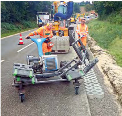
Mitarbeiter der Straßenmeisterei Langenau mit der Verlegemaschine
