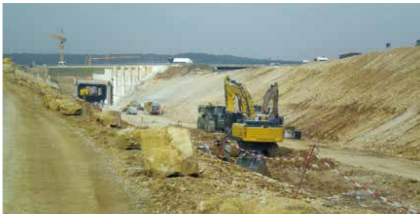
Die Großbaustelle für die DB Schnellbahntrasse.
