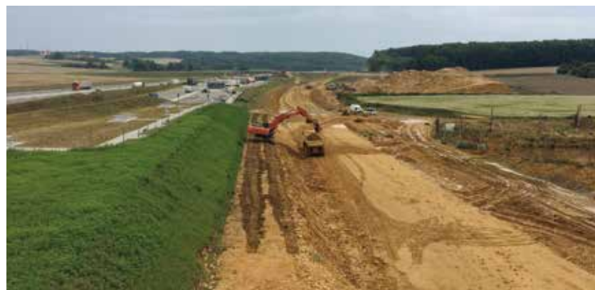
Blick von Westen auf die Baustelle Temmenhausen.
