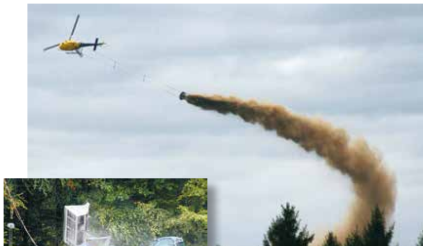
Befüllung des Kübels (links): Dieser Vorgang wiederholt sich bis zu zweihundert Mal am Tag. Ausbringung des Holzasche-Kalkgemischs mit dem Helikopter (oben).
