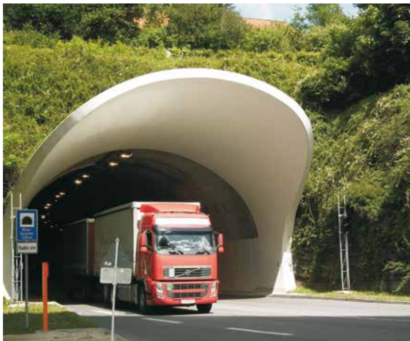
Der B 28-Tunnel bei Blaubeuren.
