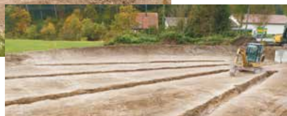
Bau des Beckens mit Ein- und Auslaufbauwerk
