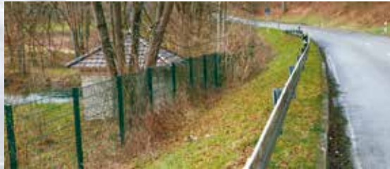
Kreisstraße 7409 vor dem Ausbau und Nähe zur Wasserfassung „Schwarzer Weiher“ (unten)
