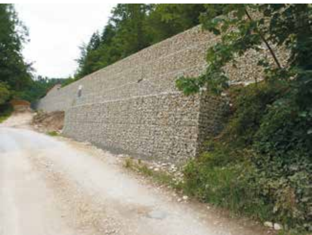
Gabionenwand zur Sicherung der Straßenböschung.
