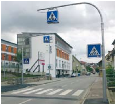
Der neu geschaffene Fußgängerüberweg in Lonsee
