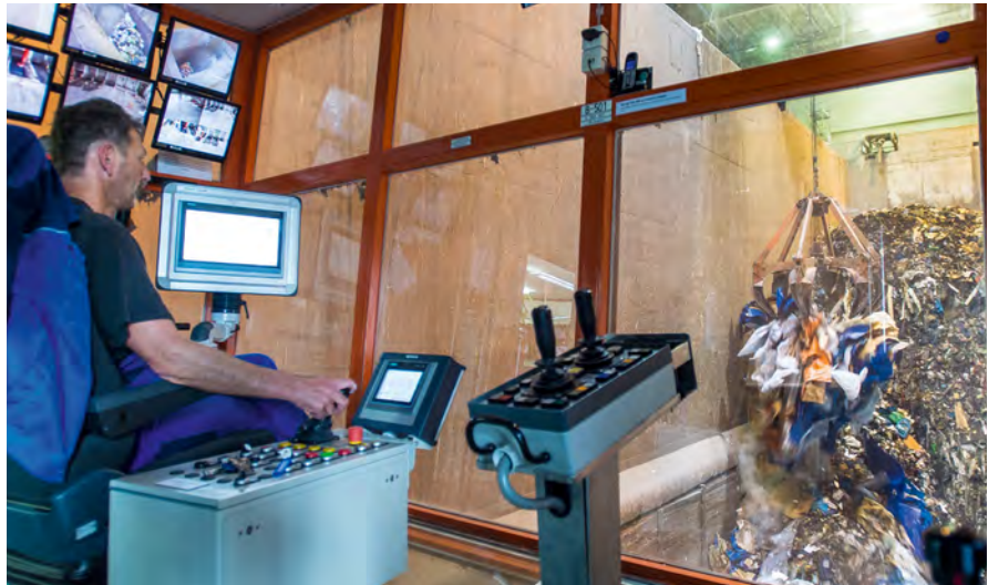
Krankanzel im Müllbunker des Müllheizkraftwerks Ulm-Donautal – hier landet auch der Hausmüll aus dem Alb-Donau-Kreis.
