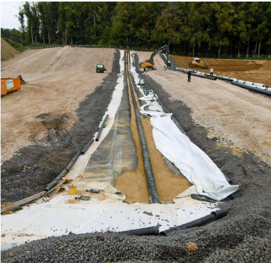
Deponie Unter Kaltenbuch – Deponieabdichtung mit Sickerwasserleitung
