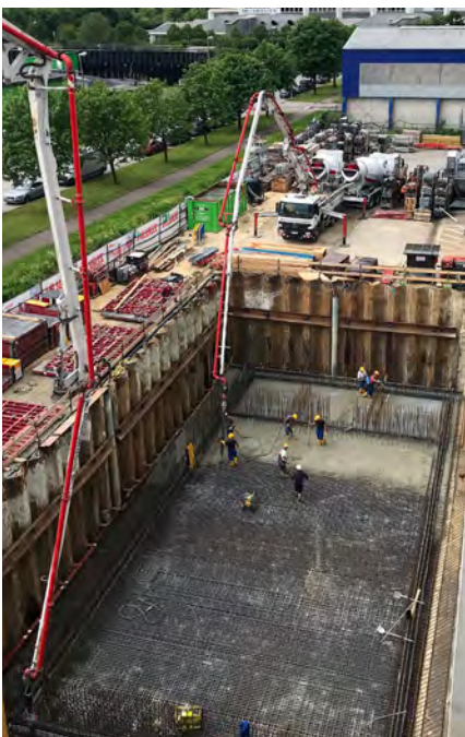
Bunkererweiterung: Bodenplatte wird eingebaut.
