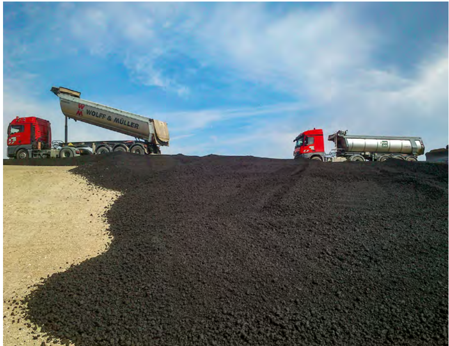
Aufbringen der Tragschicht
