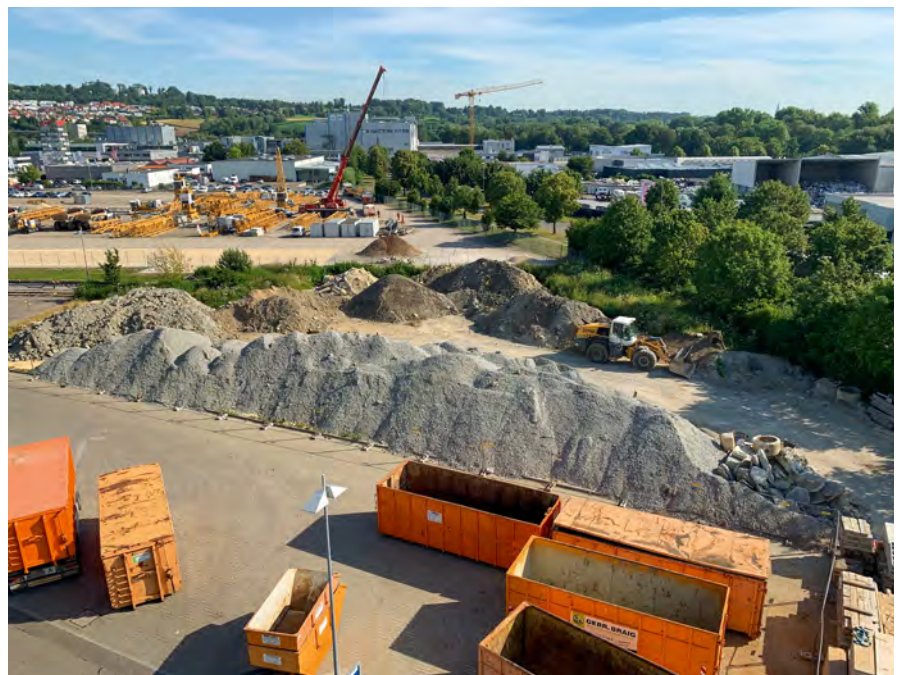
Abbruchmaterial wird zu Recyclat-Baustoffen
