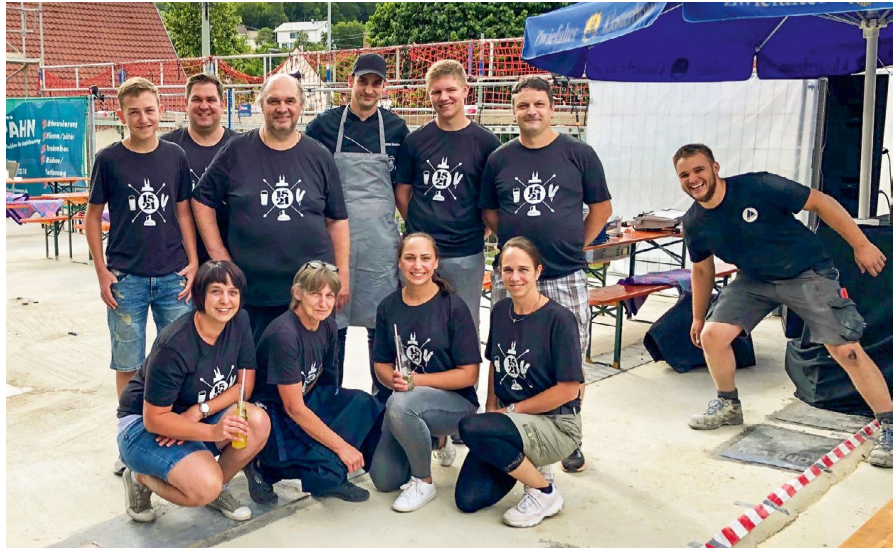
Vorbereitungen zur „Oben-ohne-Party“ im Landgasthof Krone nach dem Abriss des alten Dachstuhls
