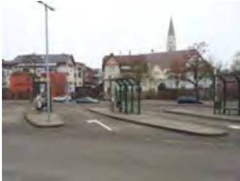
■ Abbildung 12: Ehingen Busbahnhof
