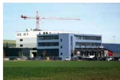
Ein neuer Gewerbebau entsteht im Gewerbegebiet Dornstadt.
