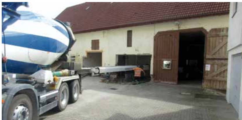
Vorarbeiten für den Umbau vom Schweinestall zur SchaubrennereiV in Emeringen.
