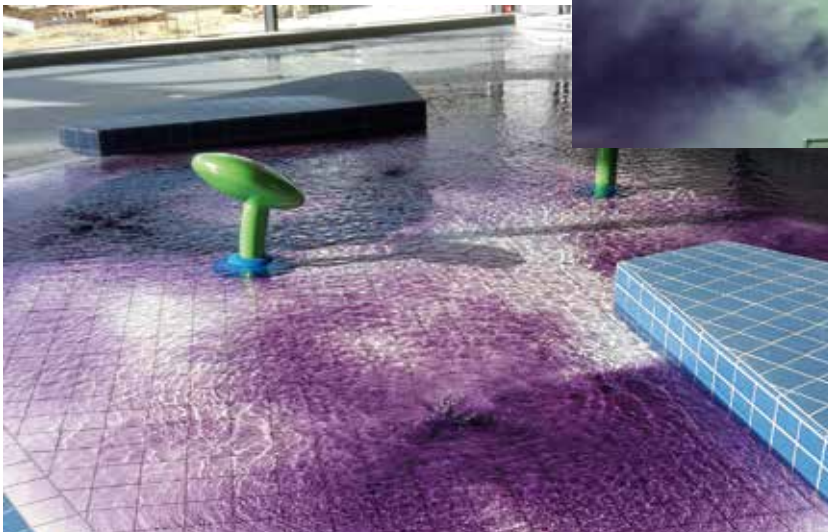
Färbeversuch im Kinderbecken eines Schwimmbads zur Überprüfung der Beckenhydraulik.
