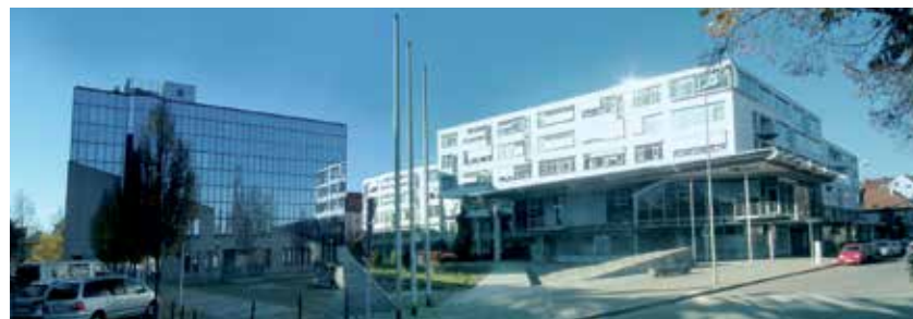
Haus des Landkreises (rechts) und daneben das Gebäude Hauffstraße 10 – dort wird der Erweiterungsbau der Kreisverwaltung entstehen.
