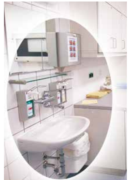
Gute Ausstattung in einem Untersuchungsraum: Handwaschbecken ohne Überlauf mit Seifen-, Einweghandtuch- und Desinfektionsmittelpender sowie einem Sammelbehälter für gebrauchte Einmalhandtücher.
