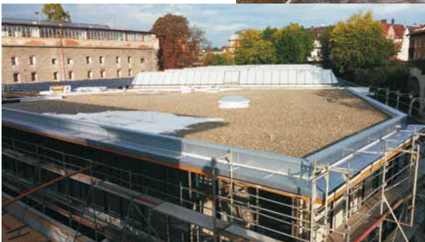
Valckenburgschule Ulm: Die Sporthalle wird erweitert. Baufortschritt – vom Abriss des alten Hausmeisterhauses bis zum neuen Erweiterungsbau.
