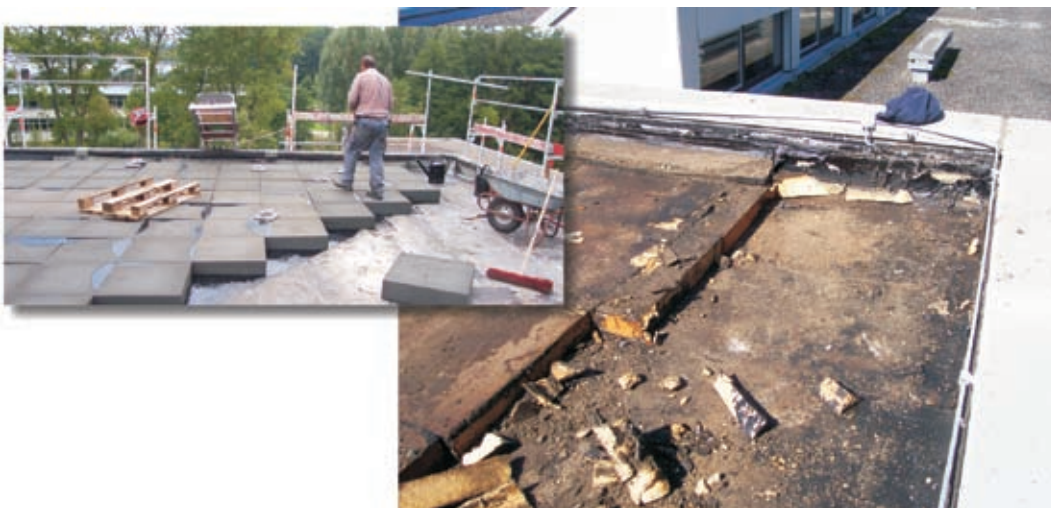
Dachsanierung bei der Gewerblichen Schule in Ehingen
