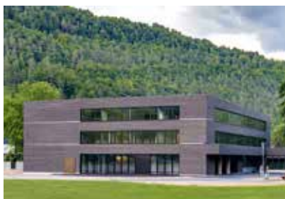
Neubau Gemeinschaftsschule Blaubeuren (Foto: Bernd Lohse, Braunschweig)
