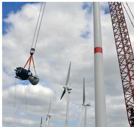
Das Getriebe mit Hauptwelle wird mit Hilfe eines Krans in die Anlagengondel eingebaut
