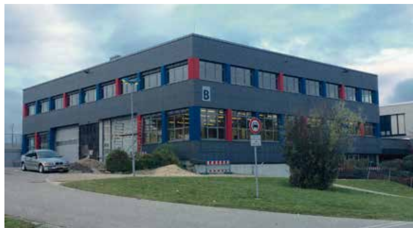
Das energetisch sanierte Werkstattgebäude B bei der Gewerblichen Schule Ehingen.
