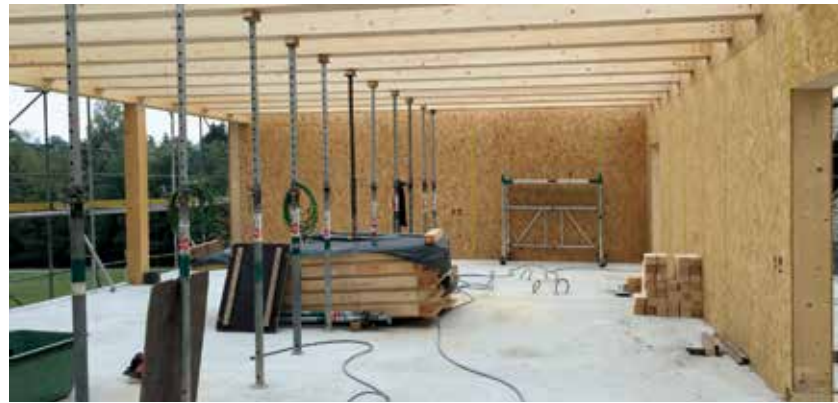
Erweiterungsbau für die Magdalena-Neff-Schule in Ehingen entsteht.
