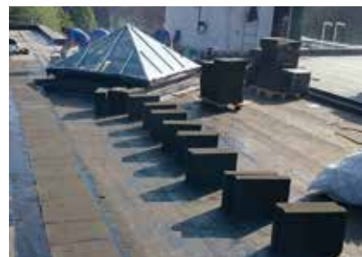
Dachsanierung mit Foamglas-Dämmung bei der Valckenburgschule Ulm.
