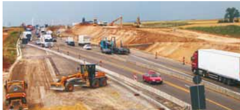
Arbeiten an der BAB A8-Trasse.
