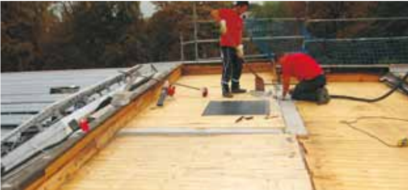
Dachsanierung bei der Valckenburgschule.
