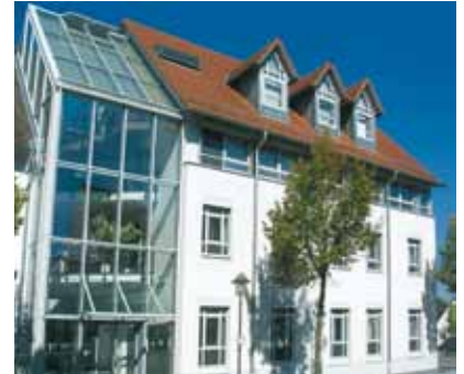
Kuffenstraße 19 in Langenau: Oben der Verwaltungsverband, unten das Mehrgenerationenhaus und die Tagesgruppe
