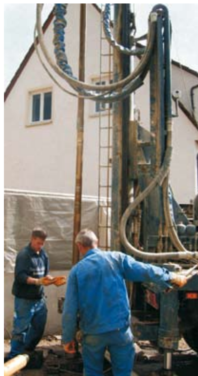
Bohrung für eine Erdwärmesonde
