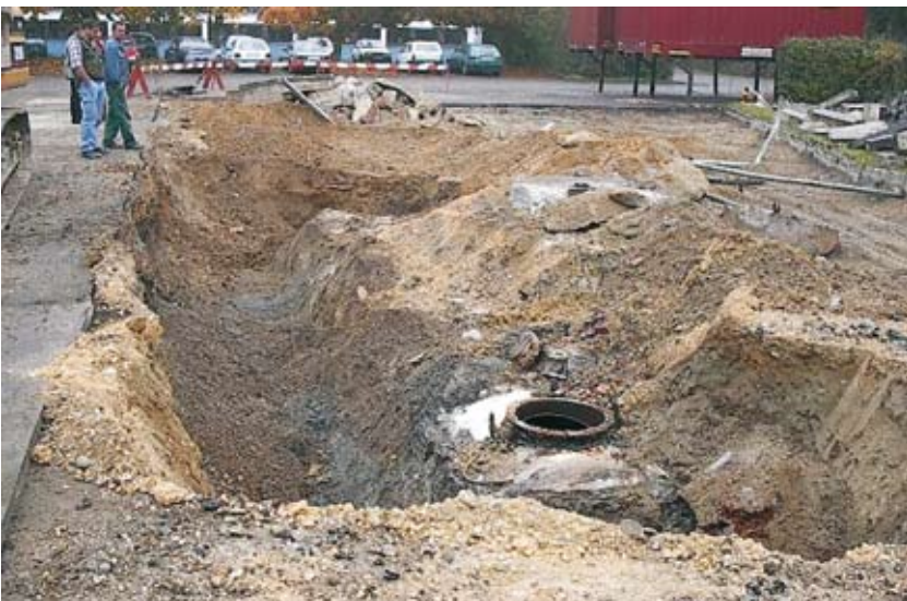
Altlast: Sanierung eines ehemaligen Tankstellengeländes
