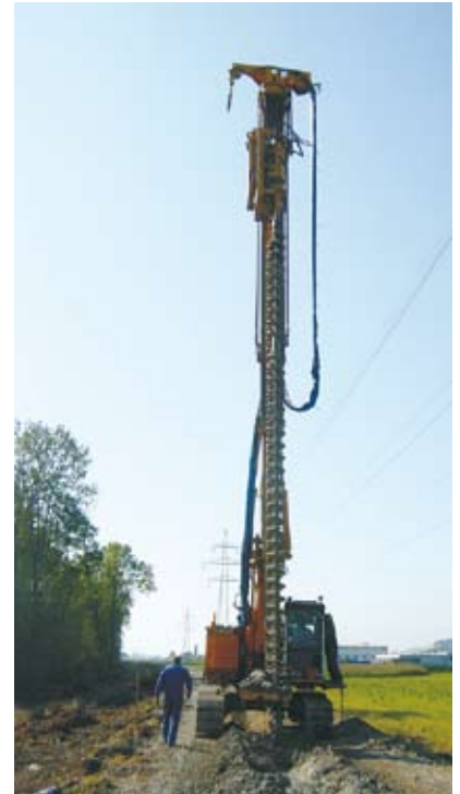
Einbau der Dichtwand auf dem Deichkörper
