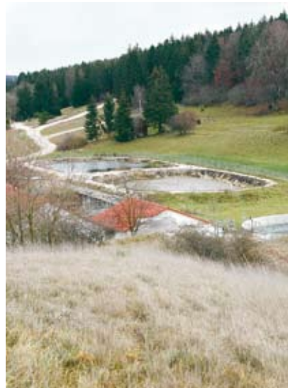
Die beiden Langsamsandfilter bei der Kläranlage in Merklingen
