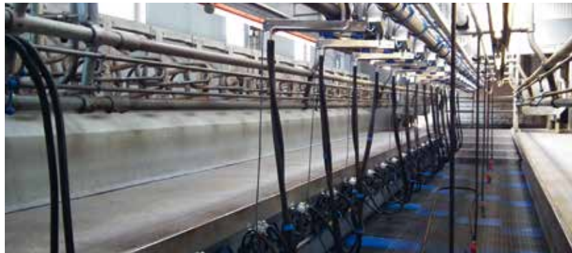
Blick in einen modernen Melkstand für Milchkühe, der wesentlich zur Verbesserung der Arbeitsqualität für den bzw. die Melker beiträgt.
