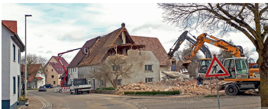
ELR-geförderte Baumaßnahme in Justingen
