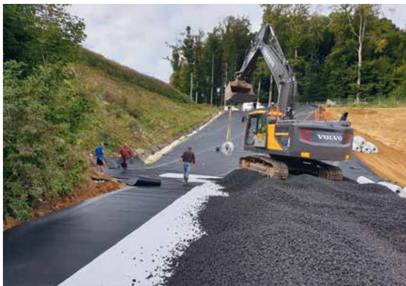
Ausbauarbeiten an der Deponie Unter Kaltenbuch.
