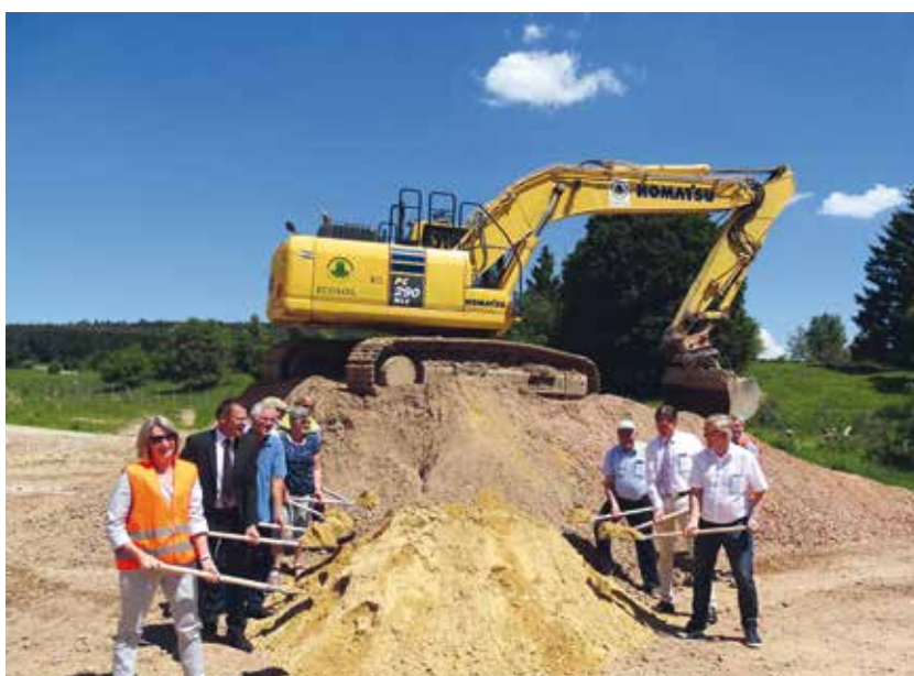
Spatenstich für den Ausbau.
