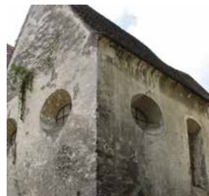
Die historische Martinskapelle in Munderkingen wird mit EU-Förderung saniert und zu einem kulturellen Treffpunkt umgebaut.
