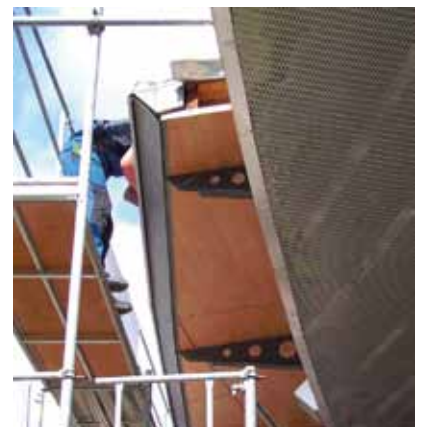
Dachsanierung bei der Gewerblichen Schule.
