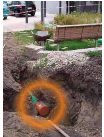
Nahwärmenetz-Leitung.
