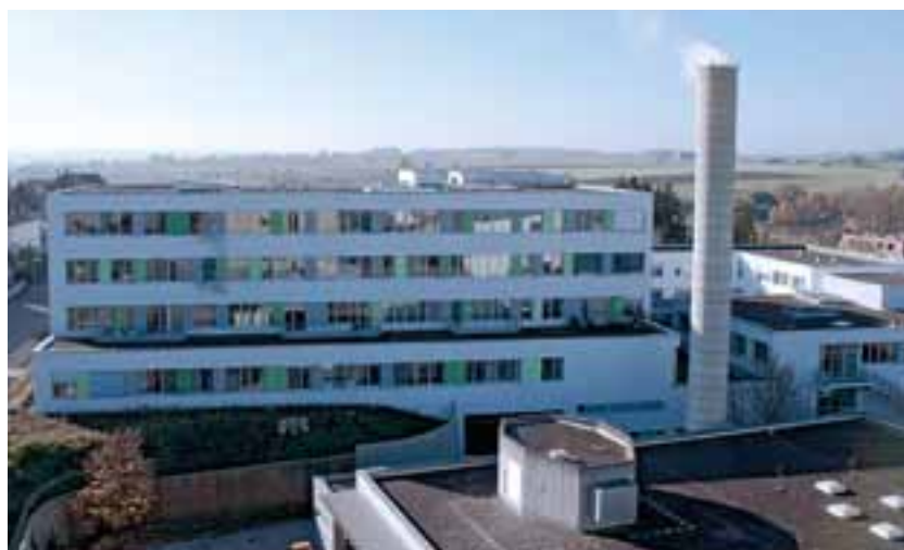
Im Erweiterungsbau des Gesundheitszentrums EHINGEN finden zahlreiche neue Angebote ihren Platz.
