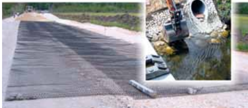
Arbeiten an der Kreisstraße bei Arnegg, u.a. mit dem Aufbringen eines „Geogitters“ (unten).
