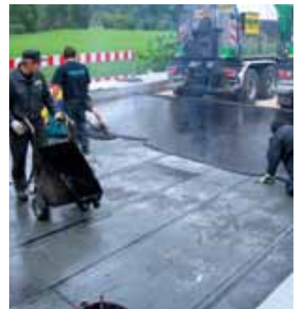
Einbau von Gussasphalt auf der Brücke.
