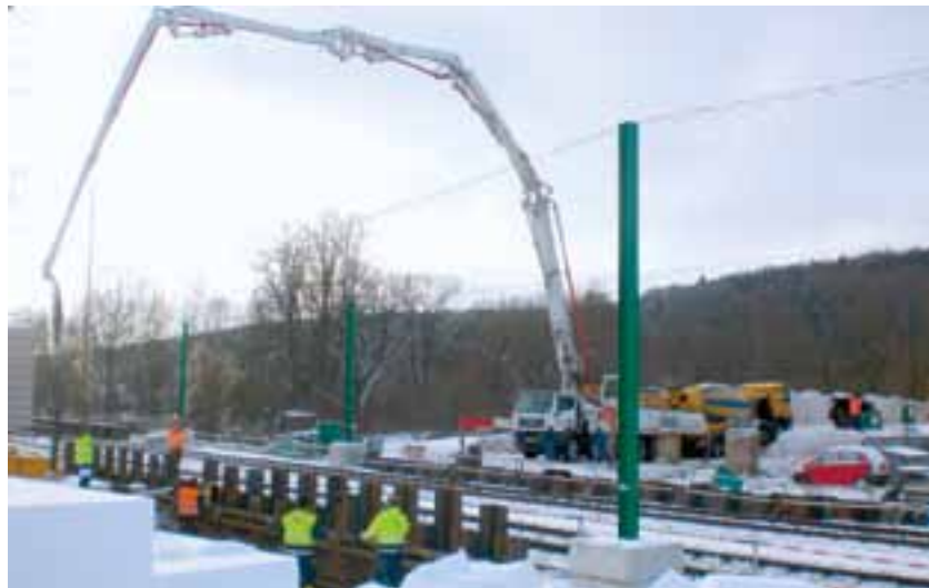
Widerlager der Brücke werden betoniert.
