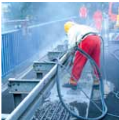
Abstrahlen einer Brückenkappe bei Erbach (K 7375).
