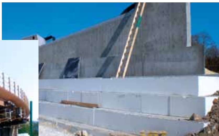
Bild oben: Styropor kommt zum Einsatz, um den Untergrund zu entlasten. Bild links: Traggerüst und Schalung von unten.
