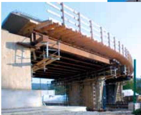
Bild oben: Styropor kommt zum Einsatz, um den Untergrund zu entlasten. Bild links: Traggerüst und Schalung von unten.
