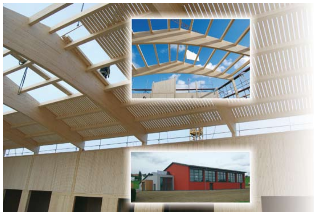
Ein Beispiel für gelungenen kommunalen Holzbau im Alb-Donau-Kreis: Die Passivhaus-Turnhalle in Ehingen-Berg, im Jahr 2009 komplett aus Holz gebaut und mit garantierten Energiekosten von weniger als 2.000 Euro im Jahr.
