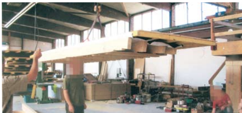
Nachgestellte Szene mit einem am Brückenkran hängendem Holzfertigteile
