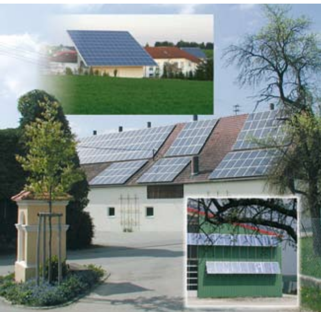
ELR-gefördert: Photovoltaik, unter anderem auf dem Dach eines landwirtschaftlichen Anwesens
