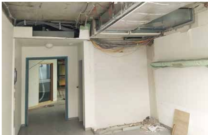
Bauarbeiten im Alb-Donau Klinikum Langenau.
