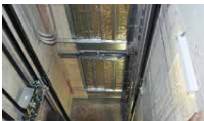
Blick in den Aufzugsschacht
