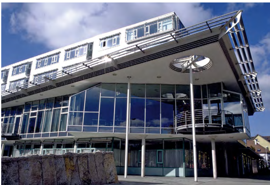
Ein architektonisches Markenzeichen – das Haus des Landkreises in Ulm.
