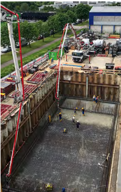
Bunkererweiterung: Bodenplatte wird eingebaut.
