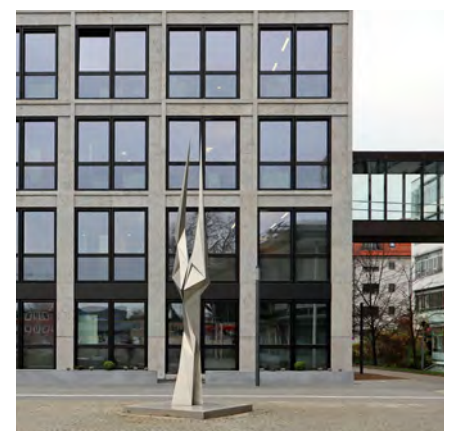
Das neue „Gebäude B“ der Kreisverwaltung – vom Rohbau bis zur Fertigstellung.
