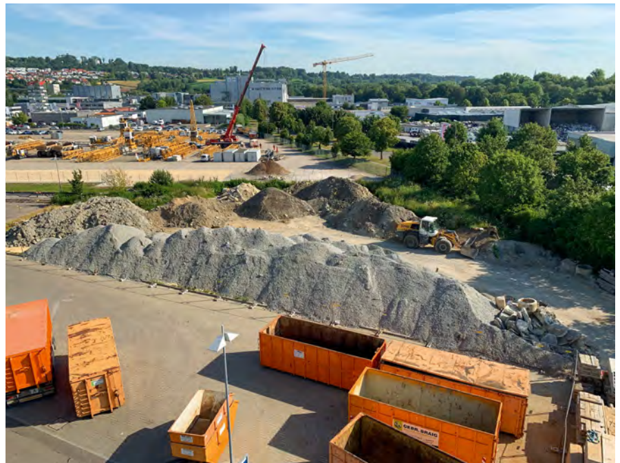
Abbruchmaterial wird zu Recyclat-Baustoffen
