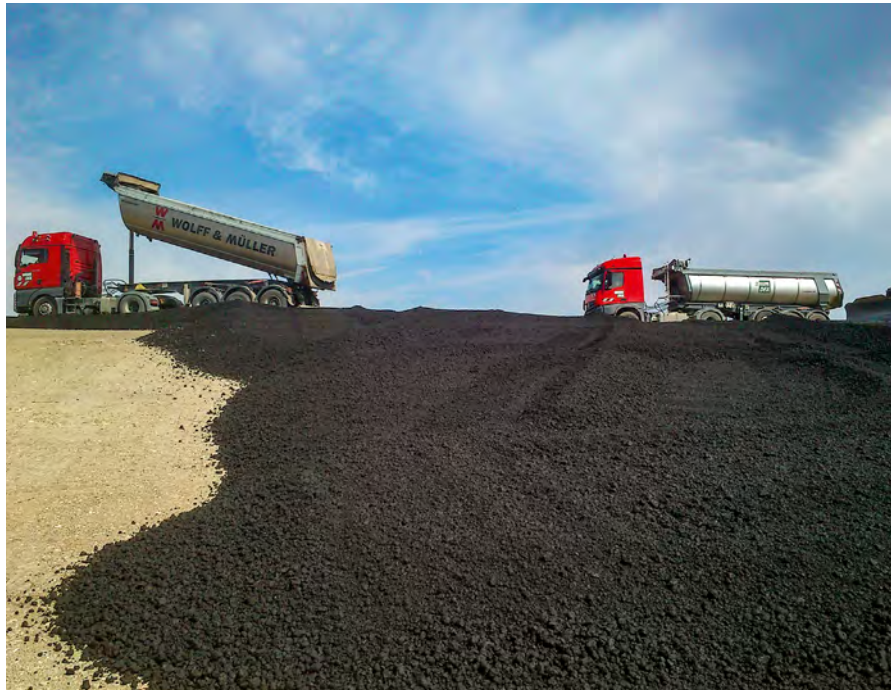
Aufbringen der Tragschicht
