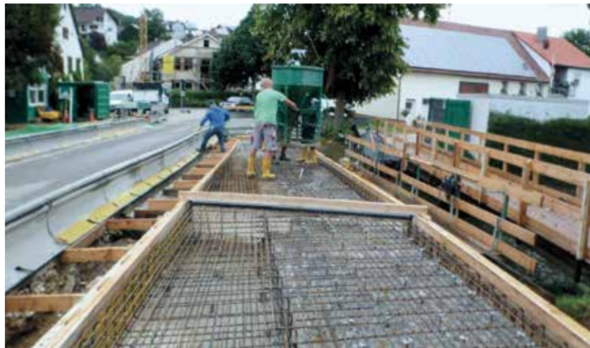
Brückenbau an der K 7339.
