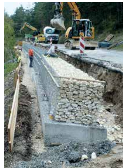
Bau einer Gabionen-Stützmauer.
