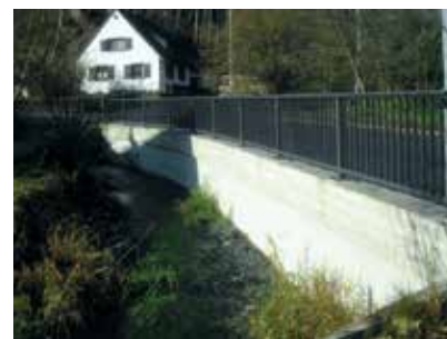
Die neue Brücke bei Sondernach.
