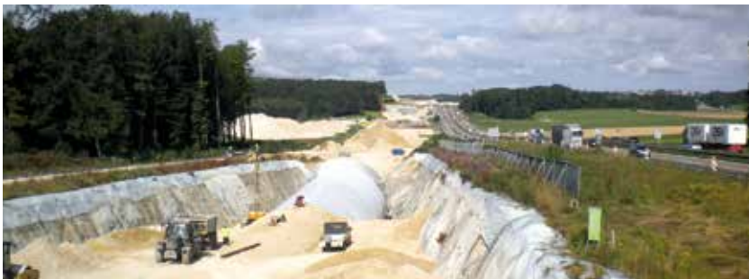
Bauarbeiten an der A8.
