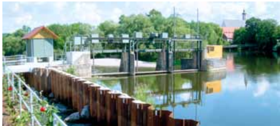
Wehranlage mit „Fischpass“ und Ausleitungskanal zum EnBW-Kraftwerk.
