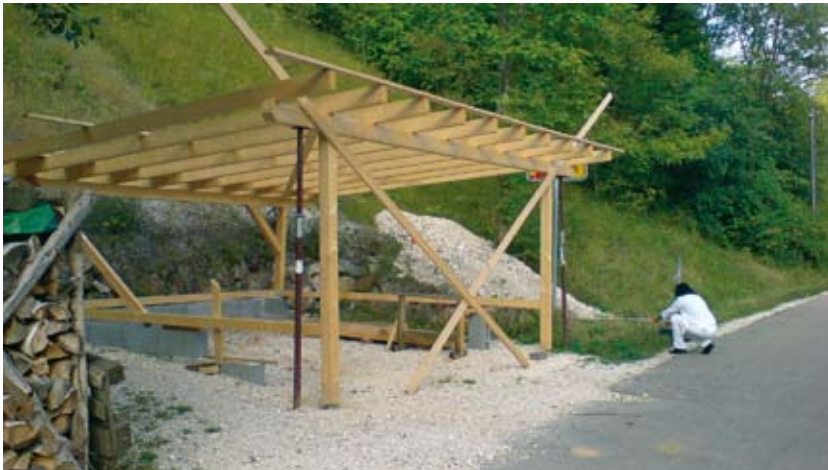
Zu nah an der Kreisstraße? Carport an der K 7384 in Lautern.
