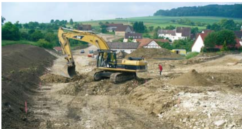
Die Ortsumfahrung Emeringen im Bau
