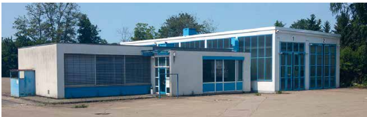
Die neue Prüftechnikhalle der Gewerblichen Schule im ehemaligen TÜV-Gebäude.
