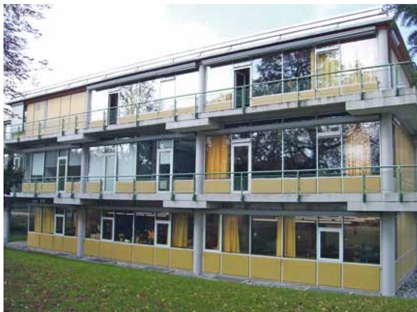
Die Valckenburgschule Ulm soll energetisch saniert werden.
