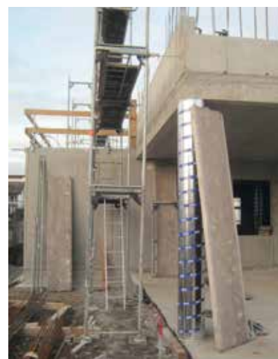
Das Ärztehaus in Dietenheim im Bau.
