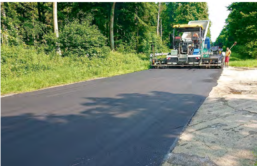
Einbau der Asphaltdeckschicht auf der Strecke Humlangen – Donaustetten
