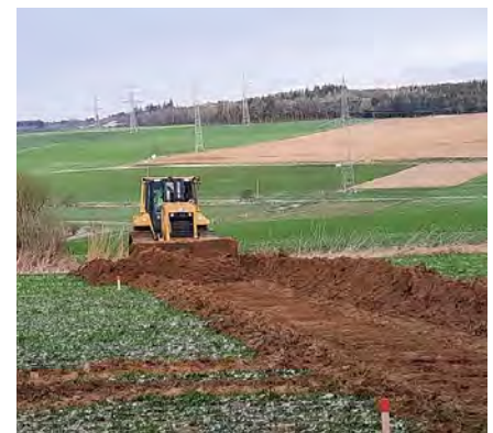
Auskoffern eines neuen Wirtschaftsweges
