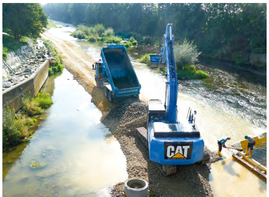
Herstellen der Baustraße in die Donau
