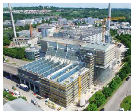
Bunkererweiterung Stand Juni 2021
