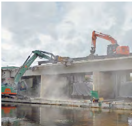
Brückenabbruch mit Bagger
