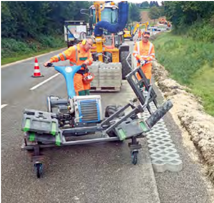
Mitarbeiter der Straßenmeisterei Langenau mit der Verlegemaschine
