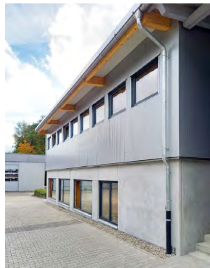
Der neue Anbau: rund 170 qm zusätzliche Werkstatt- und Schulfläche
