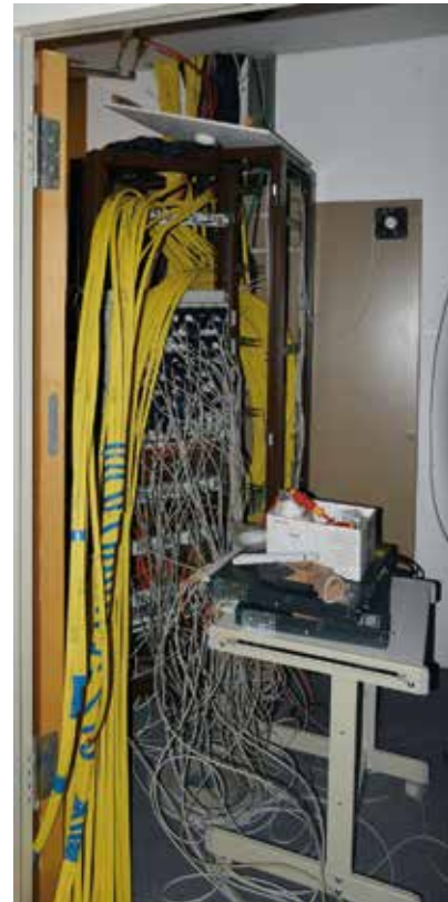
Umbau eines Verteilerschranks.
