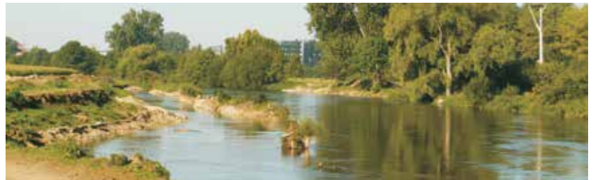
Donaurenaturierung als Ausgleichsmaßnahme für den Ausbau der „Fischerkreuzung“ in Ehingen-Berg.
